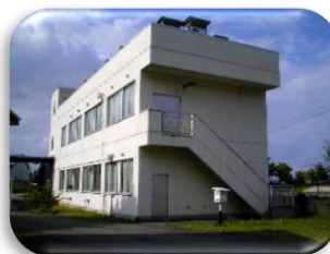
建築環境 1 号棟 空調実験室
