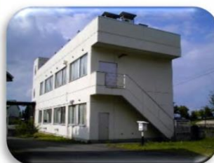
建築環境 1 号棟 空調実験室
