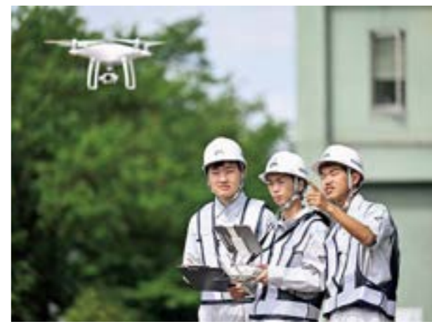
UAV による測量 (ICT 実習)
