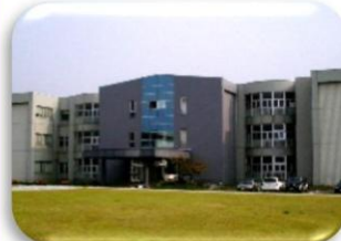
実験研究棟 環境工学実験室
